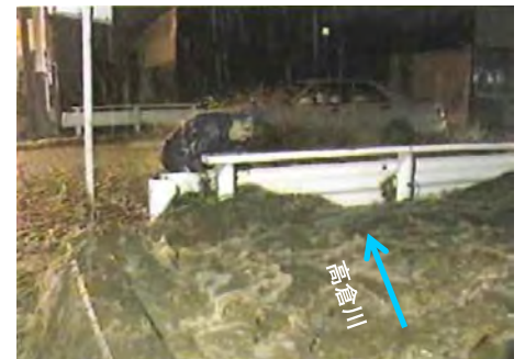
平成12年9月豪雨浸水被害状況
