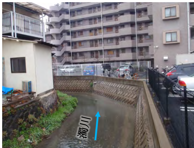
図 3-3 濁川上流状況（南深橋上流）
