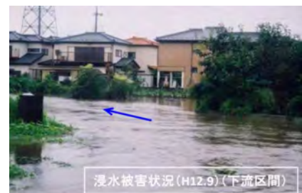
平成12年9月豪雨浸水被害状況
