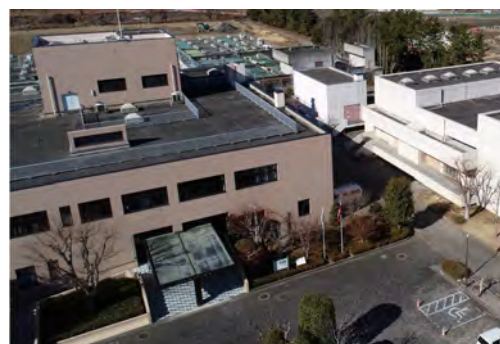
峡東浄化センター
