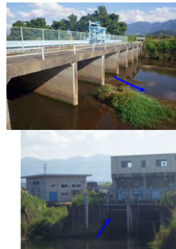
穏池排水機場
