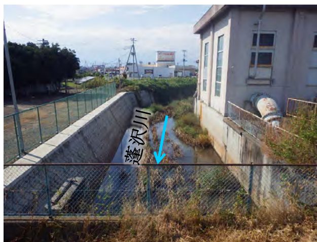
図 3-4 玉諸右岸排水機場
