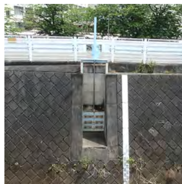
大円川第 6 排水樋門
