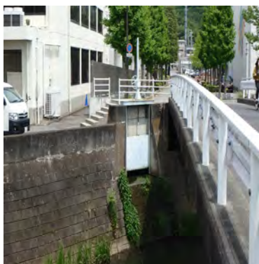
十郎川第 2 排水樋門
