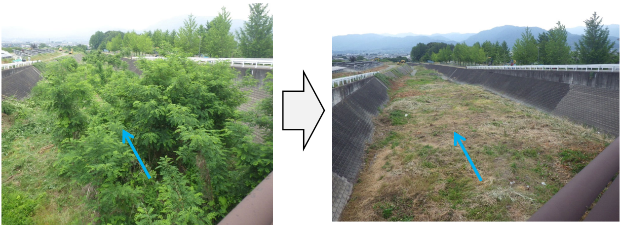
図 4-5 伐木浚渫の実施(県内事例:坪川)
