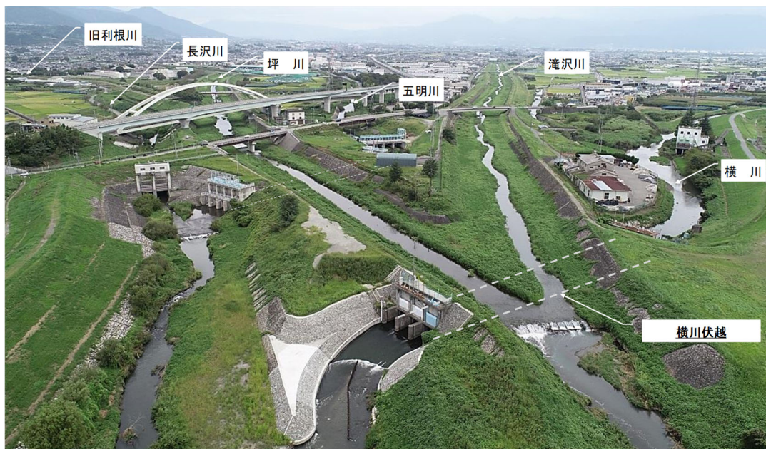
写真 3-1 横川伏越周辺の河川交差状況
