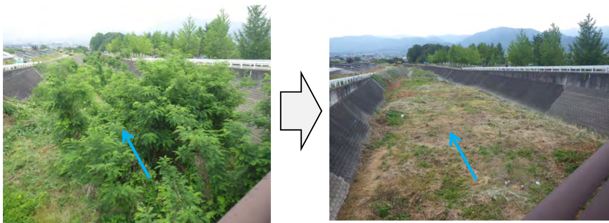
図 4-5 伐木浚渫の実施(県内事例:坪川)
