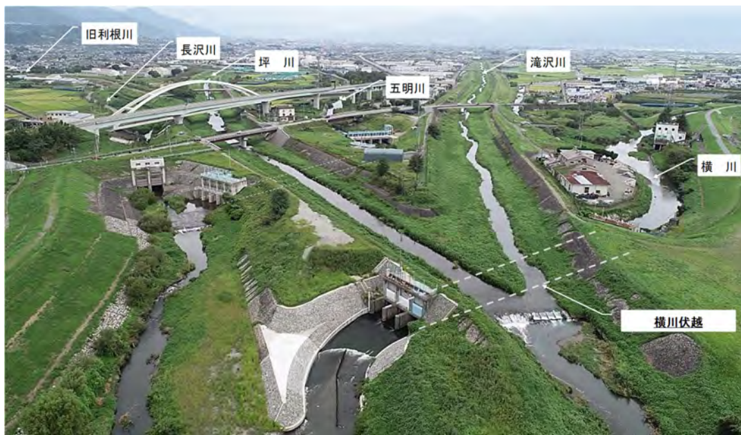
写真 3-1 横川伏越周辺の河川交差状況
