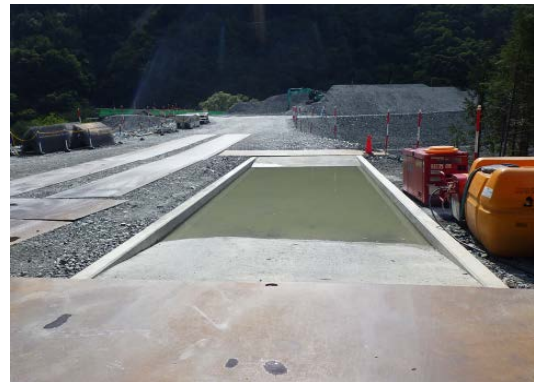
写真 6-6-4 タイヤ洗浄プール (塩島地区(河川側)発生土仮置き場)
