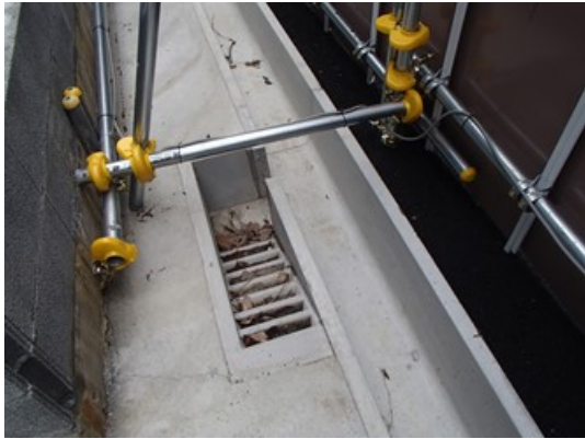
写真6-4-12(1) 小動物が脱出可能な側溝
