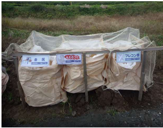
写真6-8-7 建設副産物の分別・再資源化
