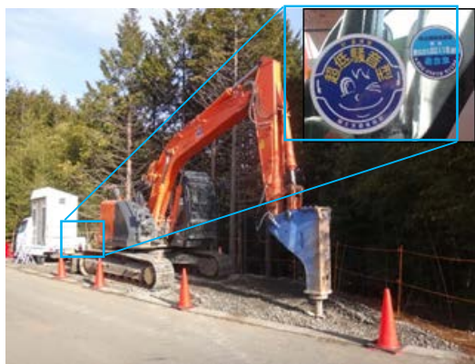
写真6-3-1 排出ガス対策型・低騒音型 建設機械の採用
