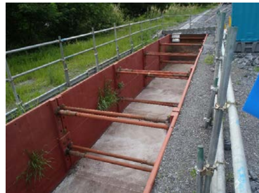
写真 6-6-6 沈砂池の設置 (塩島地区(河川側)発生土仮置き場)
