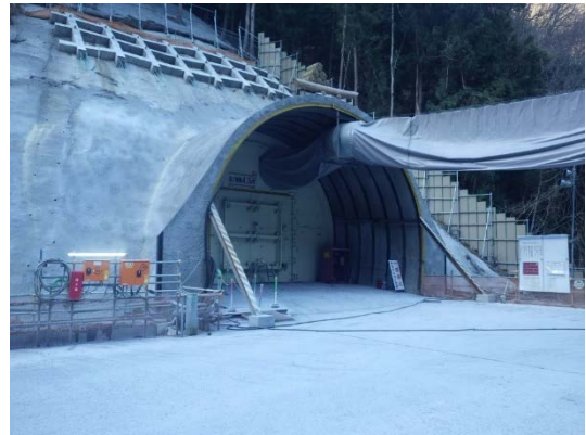
写真 6-5-16 防音扉の設置 (広河原非常口)
