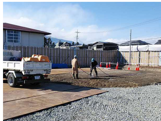
写真6-1-6 粉じん飛散防止剤散布
