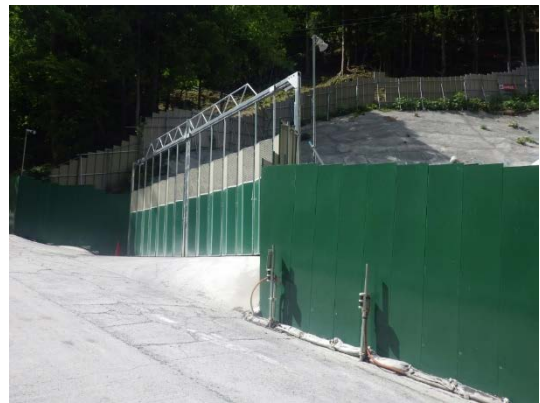
写真 6-5-6 仮設物の色合いへの配慮 (広河原非常口仮囲い)
