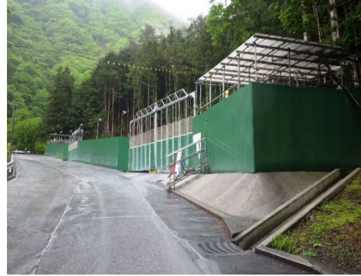
写真 6-5-14 侵入防止柵の設置 (広河原非常口)
