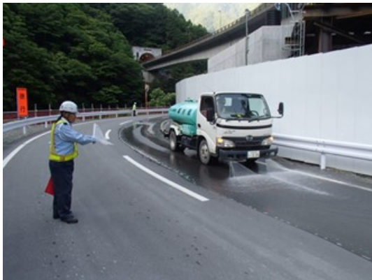
写真6-4-7 道路への散水
