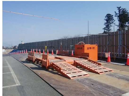
写真6-2-9 (2) タイヤ洗浄(湿式スパッツ)
