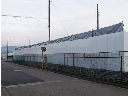
写真6-1-7 仮囲いの設置
