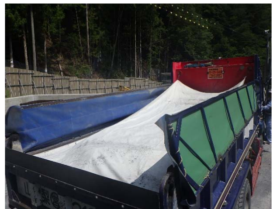
写真 6-7-6 運搬時の浸透防止シート 設置状況
