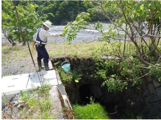
写真 6-6-7 工事排水の監視 (塩島地区発生土置き場)
