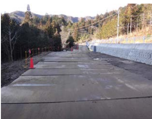
写真6-3-6 敷鉄板設置による粉じん抑制状況
