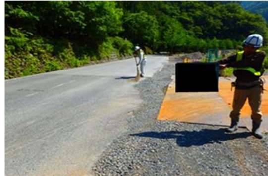
写真 6-7-4 清掃実施状況 (塩島地区(南)発生土仮置き場)
