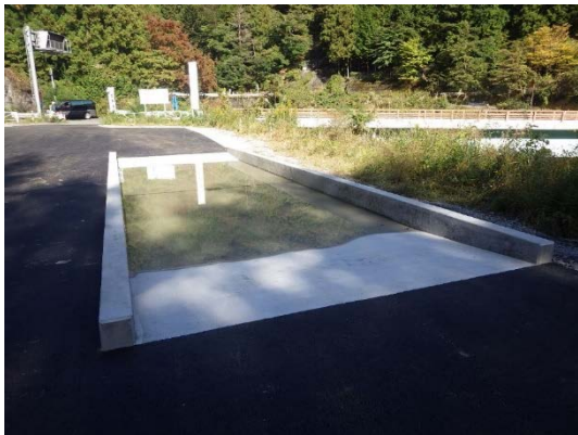
写真 6-5-9 外来種の拡大抑制 (タイヤ洗浄プール) (広河原非常口入口)
