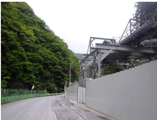
写真 6-5-5 仮囲いの設置 (早川非常口)
