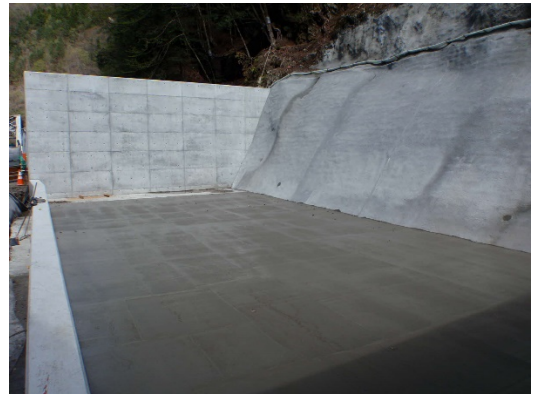
写真6-4-11(2) 土砂ピットにおける掘削土砂の管理（底盤及び周囲のコンクリート打設）
