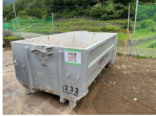
写真6-3-8 建設副産物の分別・再資源化
