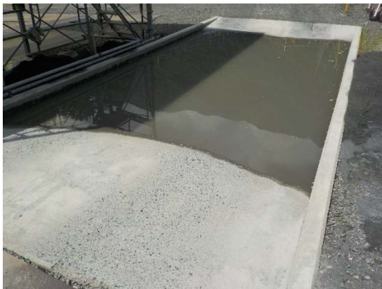
写真 6-7-5 タイヤ洗浄プール (塩島(下流)発生土仮置き場)
