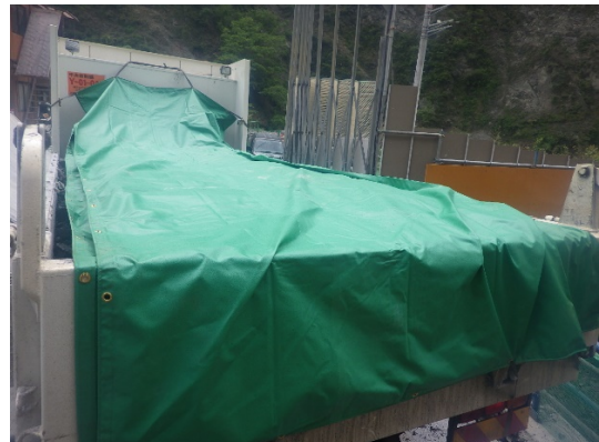
写真 6-5-12 運搬時の浸透防止シート 設置状況
