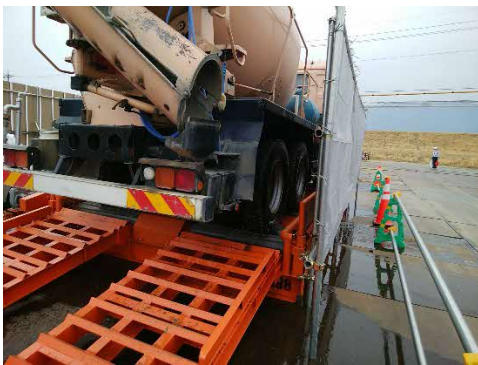
写真6-1-8 (2) タイヤ洗浄 (湿式スパッツ)
