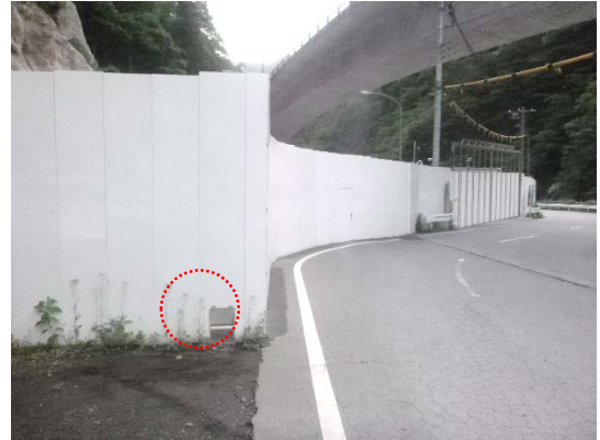
写真6-4-12(2) 小動物が脱出可能な仮囲い
