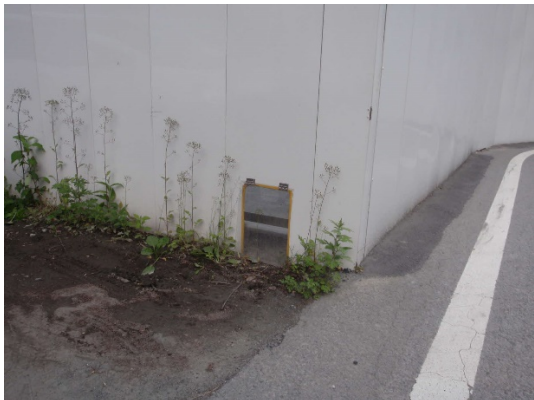
写真6-4-12(3) 小動物が脱出可能な仮囲い
