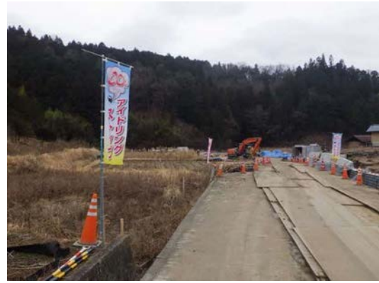
写真6-8-2 建設機械の使用時における配慮
