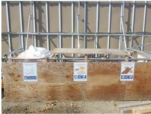
写真6-2-12 建設副産物の分別・再資源化
