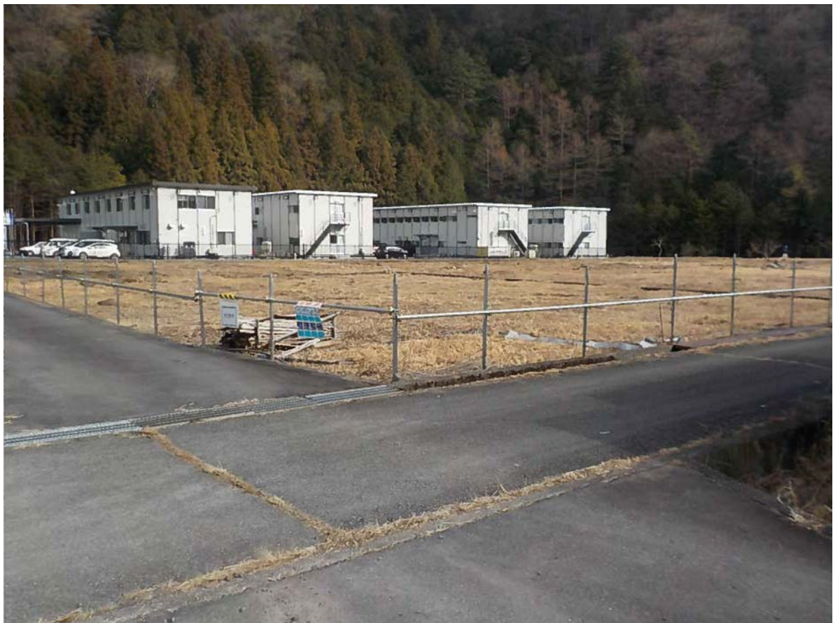
写真 2-2 中洲地区発生土仮置き場計画地の現況（近景）
