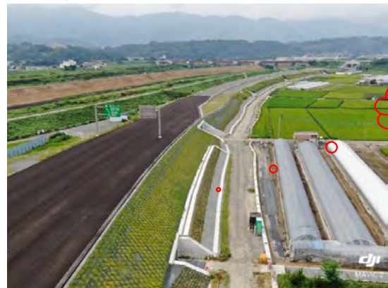
法尻防草ブロック工 施工済み
