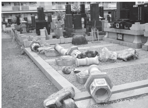
墓所で多くの石塔が倒れた。
