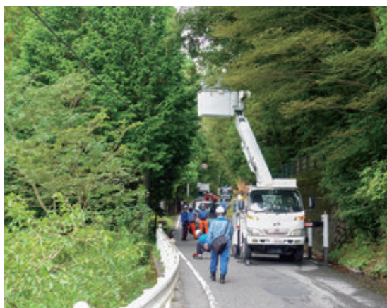
安定した電力供給に向け、事前伐採を実施
