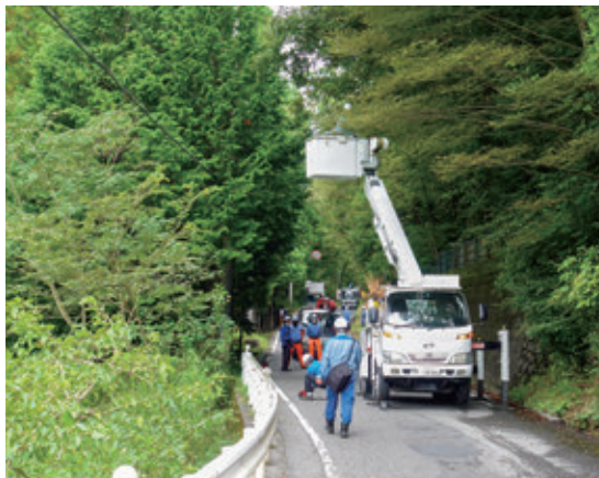
安定した電力供給に向け、事前伐採を実施
