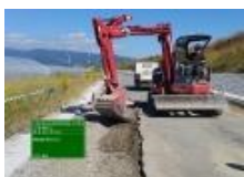
機械掘削状況
