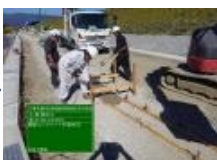
基礎コンクリート打設
