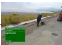
基礎砕石転圧状況
