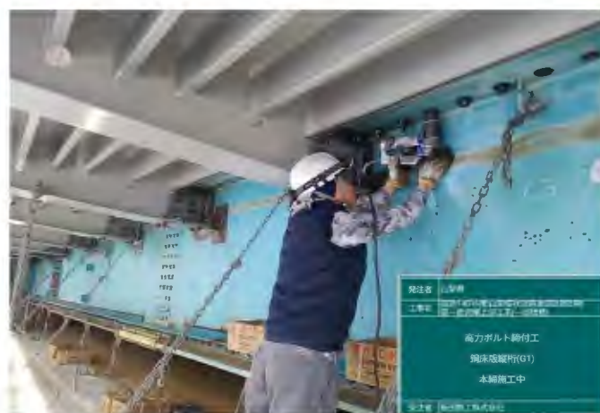
高力ボルト締付状況
