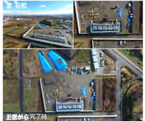
橋台-躯体工1リフト施工状況(ドローン空撮)
