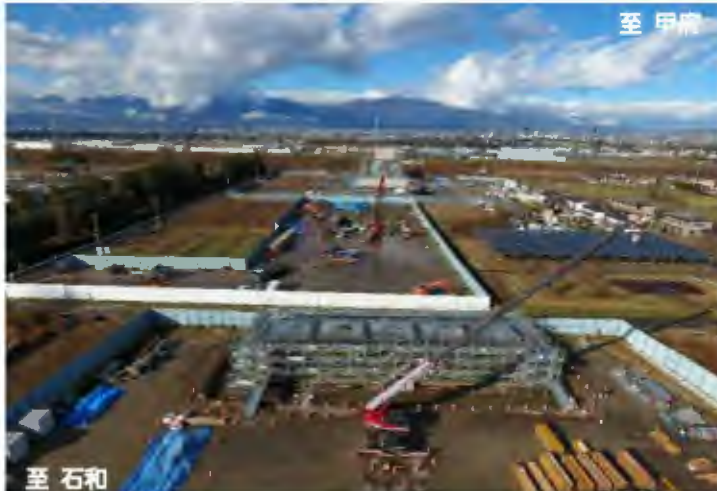
橋台-躯体工1リフト施工状況(ドローン空撮)
