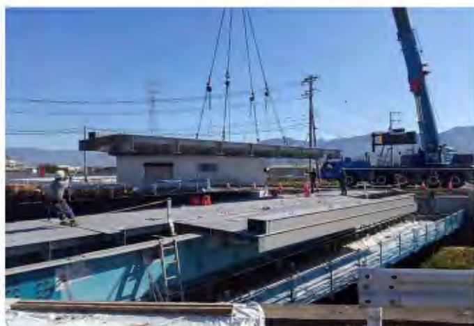
鋼床版設置状況
