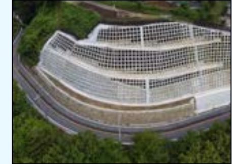
国道413号道路災害防除工事の施工後
