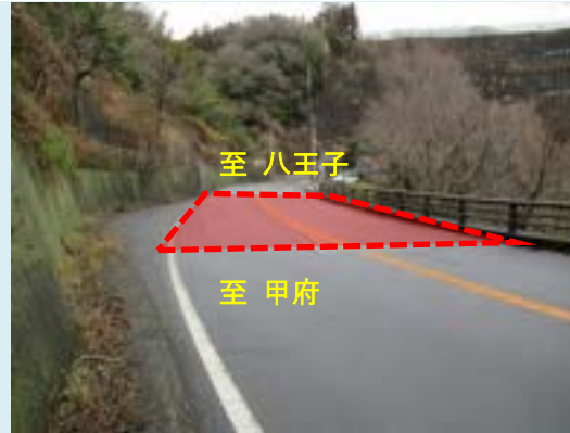
② ないちさんどう 第1棧道橋 【橋梁補修】主桁補修、支承補修等
