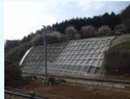
JR中央本線の復旧状況
