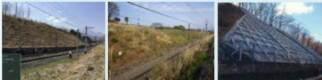
①新府・穴山間(施工前)
