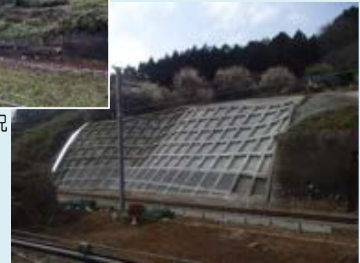
③吹付格子砕工・排水設備整備
