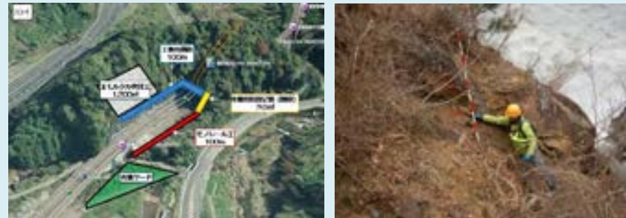
③初狩・笹子間 (施工概要イメージ(モルタル吹付工))
