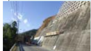
国道413号 工事中
