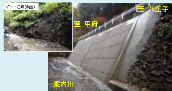
② はちおうじしみなみあさかわまち 八王子市南浅川町 大型ブロック積みによる復旧完了
