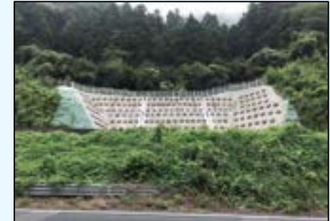
中央自動車道 小仏地区の復旧状況
