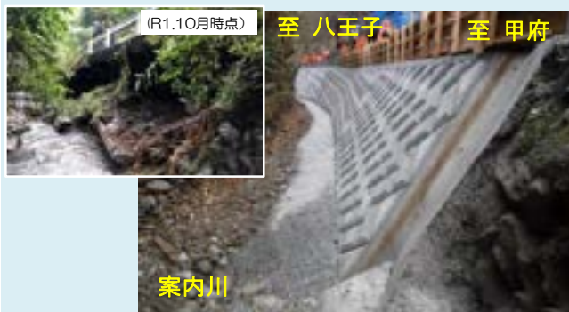
① はちおうじしみなみあさかわまち 八王子市南浅川町 ブロック積擁壁による復旧完了
