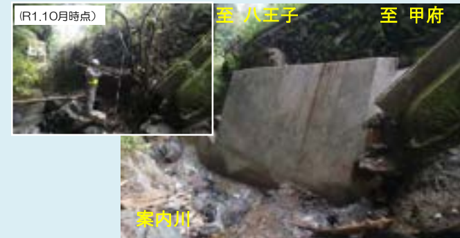
③ はちおうじしみなみあさかわまち 八王子市南浅川町 根継工による復旧完了
