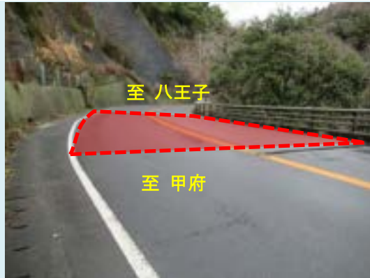
① ないさんどう 第2棧道橋 【橋梁補修】主桁補修、支承補修等
