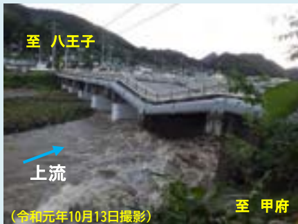
【法雲寺橋の被災状況】
