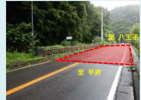
③ 大垂水橋 【橋梁補修】主桁補修、床版補修等
