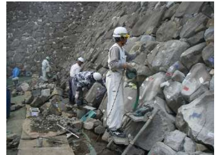
石垣の補修工事の様子
