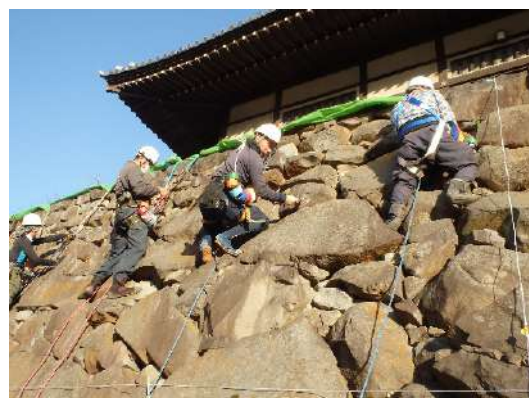
第〇図 二次点検の様子
