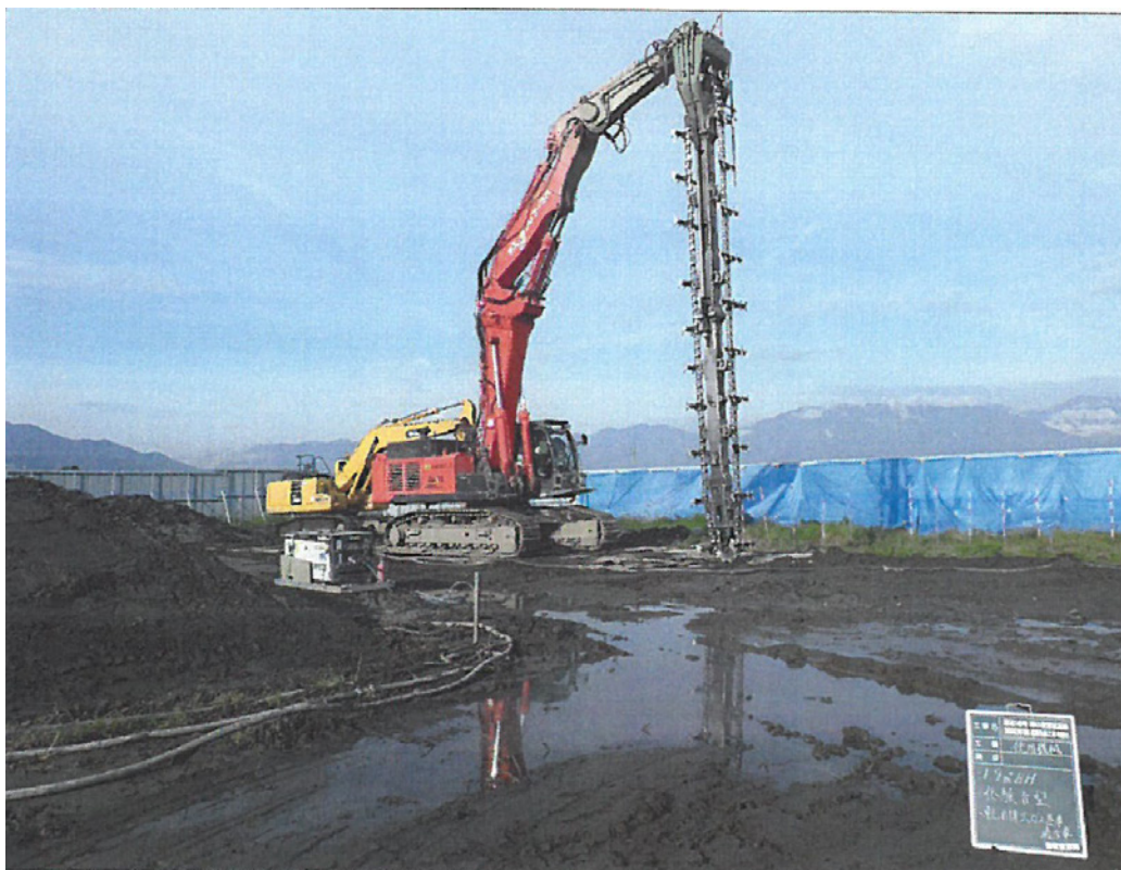
11工区で使用したトレンチャー式攪拌機
