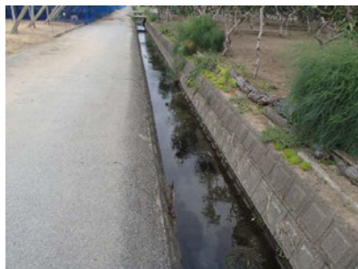
区間③：広瀬地区水路の概況
