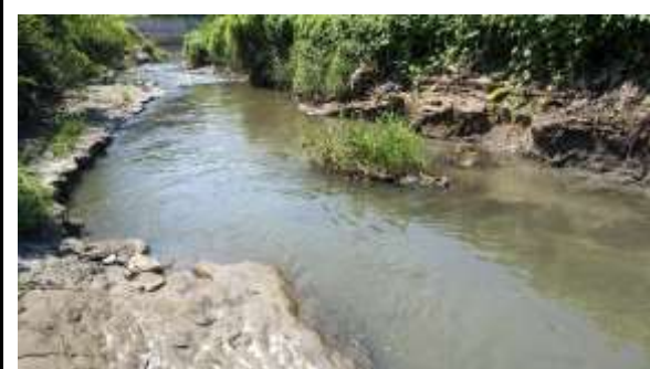
調査地点 大津西橋架橋下付近
