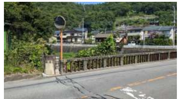
桜橋 周辺状況
