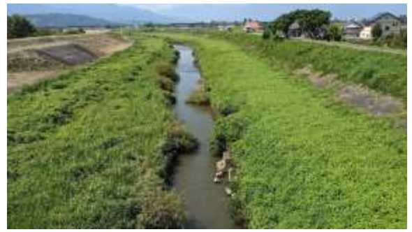
濁川橋 濁川下流側
