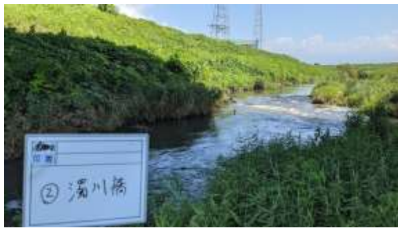
調査地点 濁川橋架橋下付近
