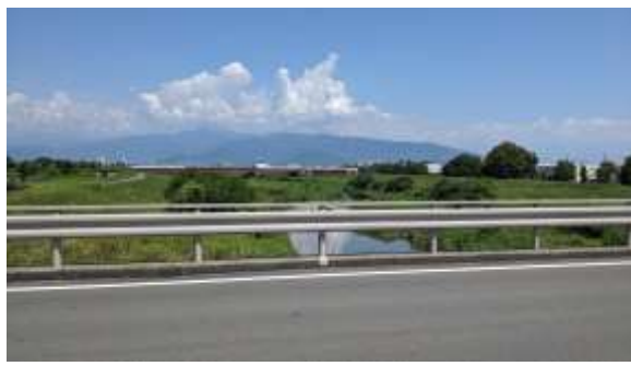
二川橋 荒川上流側
