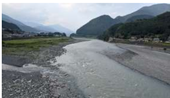
南部橋 富士川上流側
