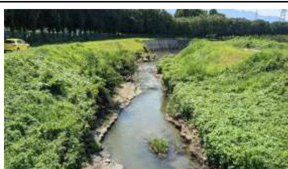
大津西橋 鎌田川下流側
