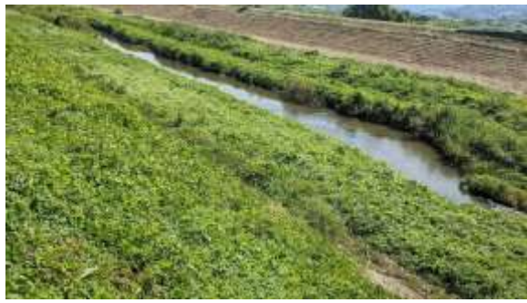
濁川橋 濁川上流側
