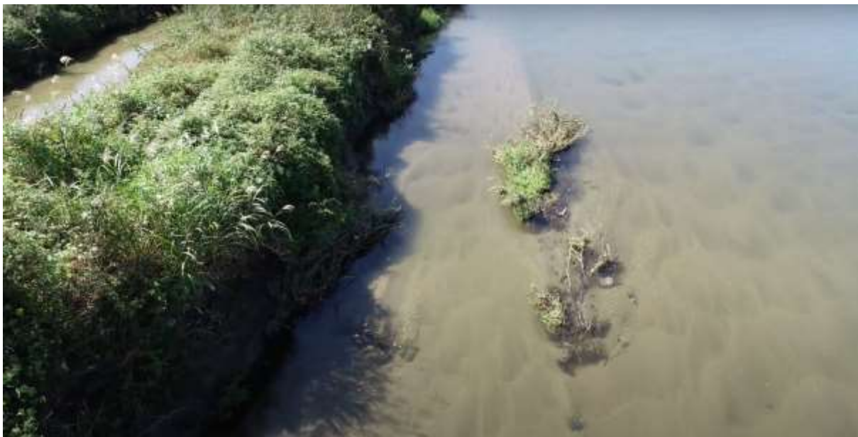
図10 笛吹川 豊積橋付近で撮影した空撮画像
