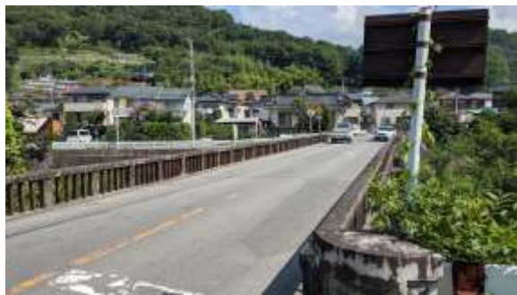
桜橋 周辺状況
