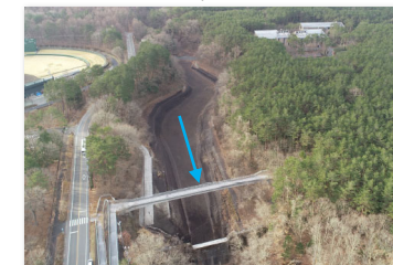
既存砂防堰堤の除石（宮川）
