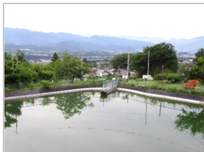
下流域に住宅がある農業用ため池
