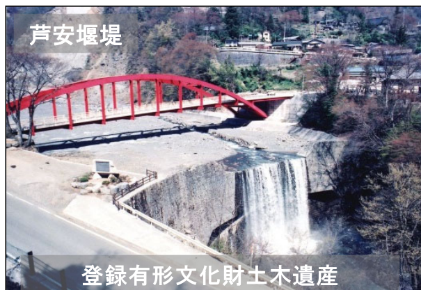
上流部に設置された砂防堰堤
