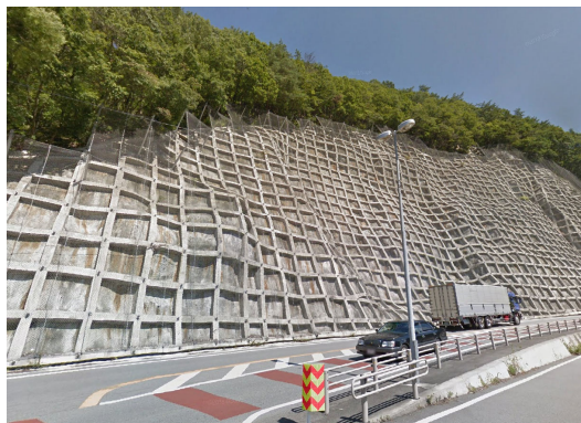
道路法面对策（国道358号）
