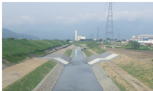
河道拡幅・堤防強化（鎌田川）
