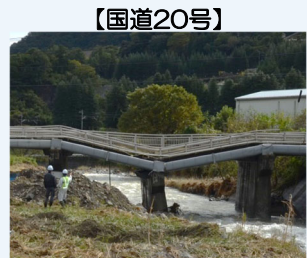
橋脚沈下による交通の寸断
