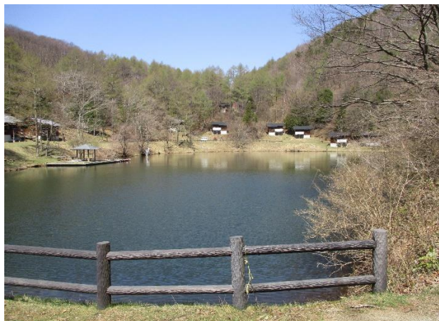
① 平久保ため池(上) 全景 貯水量 3,000m 3 、堤高 H=4.7m
