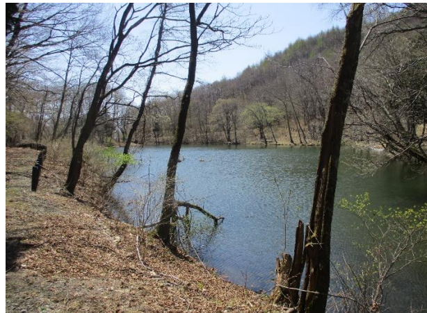
② 平久保ため池(下) 全景 貯水量 3,000m 3 、堤高 H=6.0m
