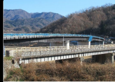
富士橋(建設中)
