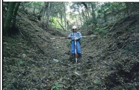
荒廃状況写真①
