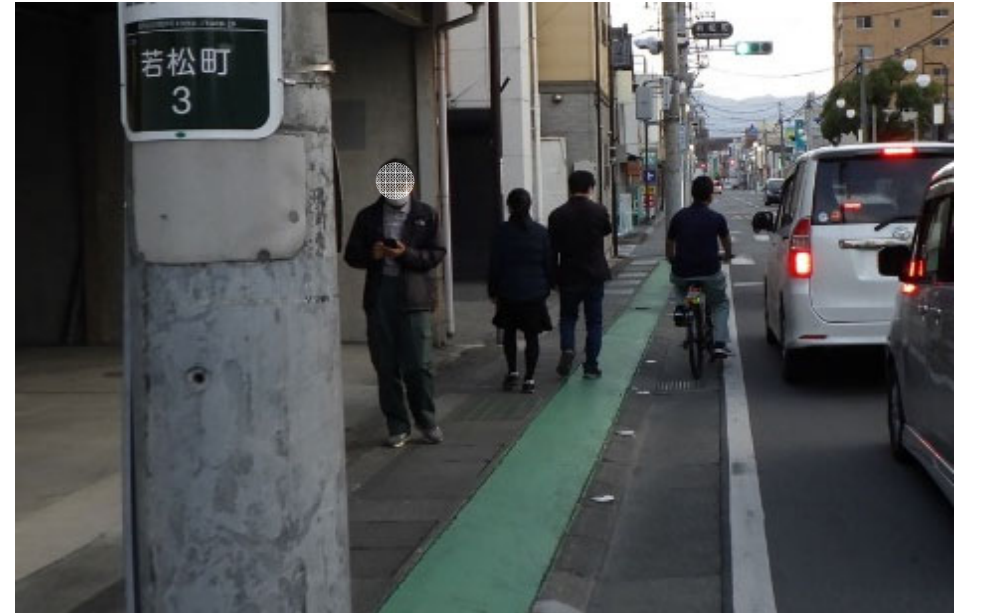
⑤歩道内に電柱が設置された歩道の通行状況
