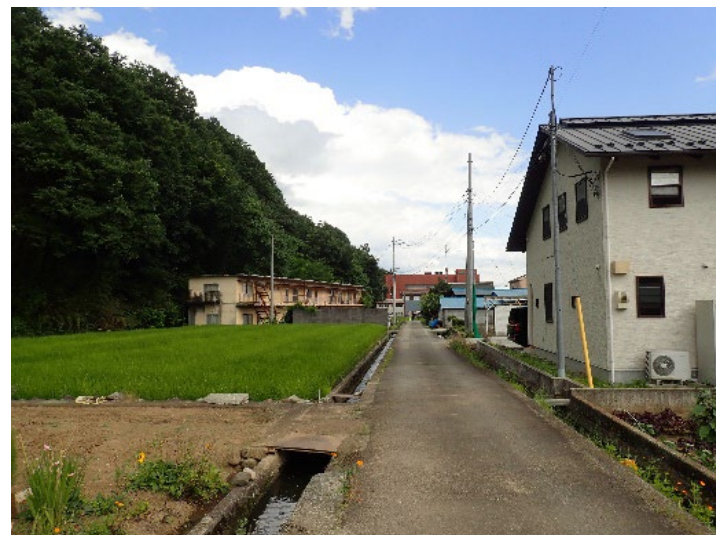
保全対象：人家、葦崎23号線（避難路）
