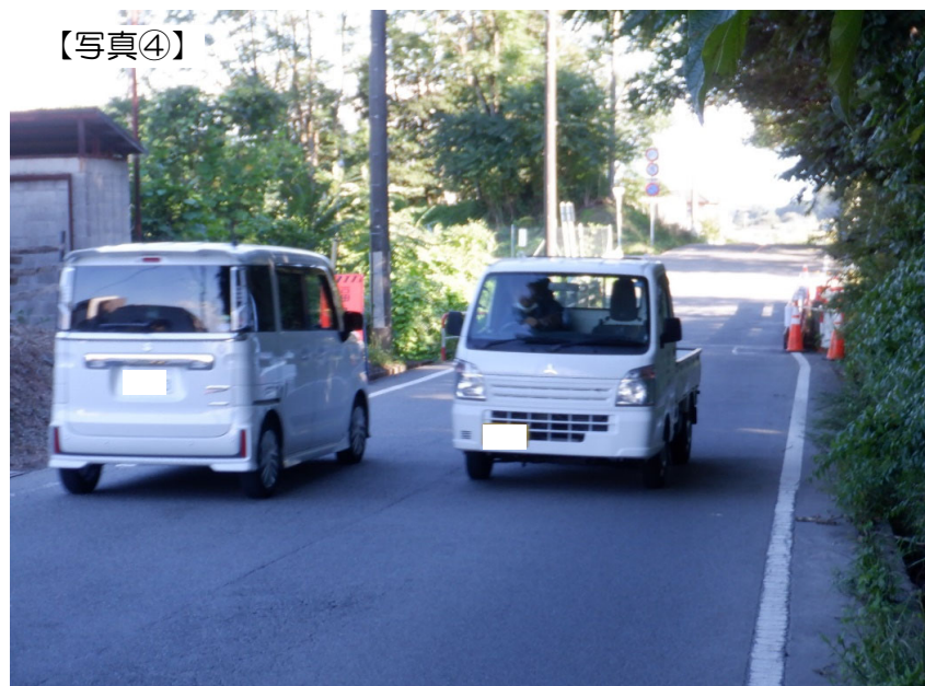
センターラインが無く幅員が狭い状況
