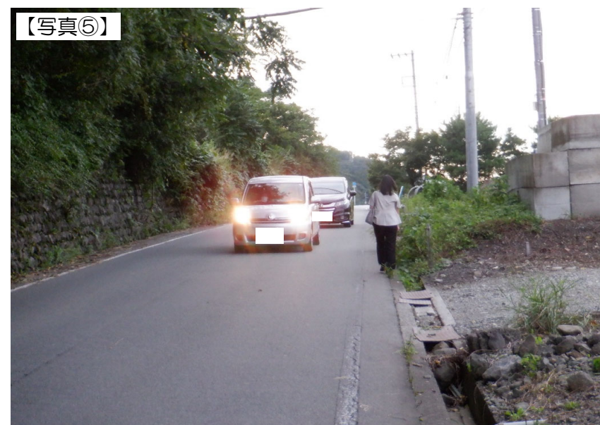
歩道が無く危険な状況
