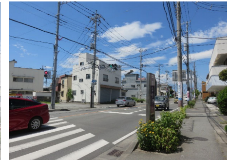
写真② 電柱、電線類の状況
