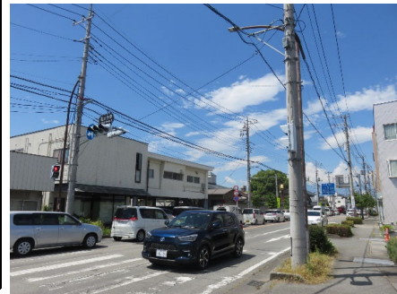
写真① 電柱、電線類の状況
