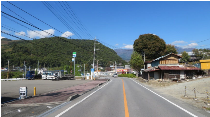
【写真①】 災害時に倒壊の恐れのある電柱
