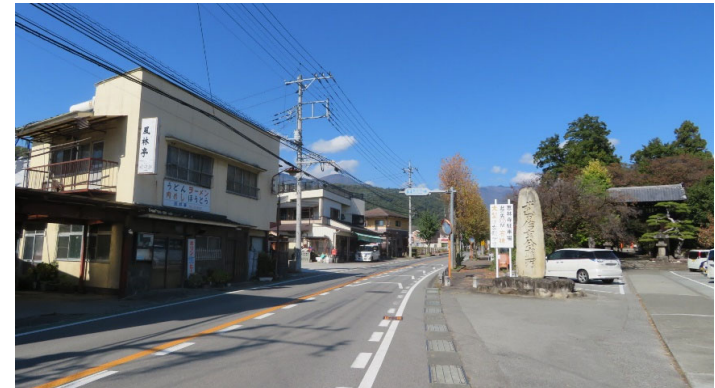
【写真②】 災害時に倒壊の恐れのある電柱
