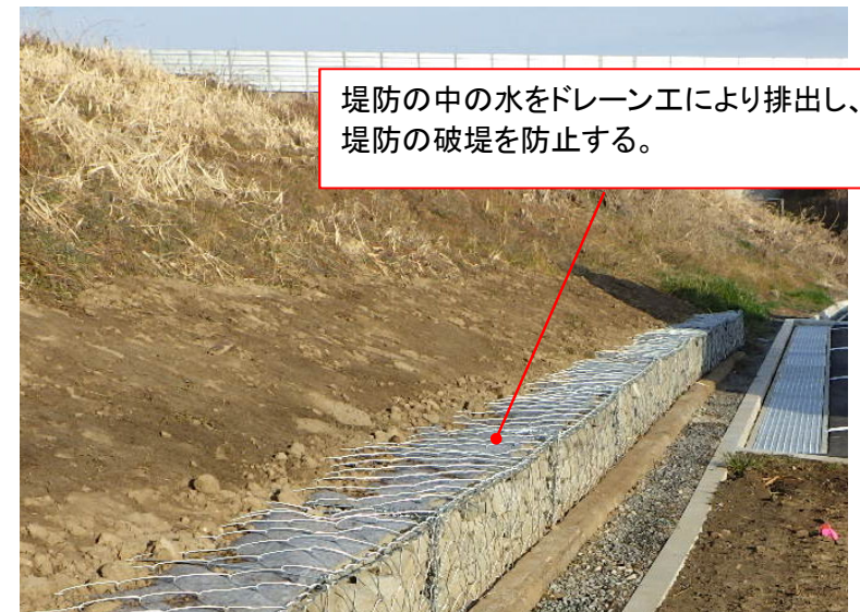
④ ドレーン工の整備イメージ
