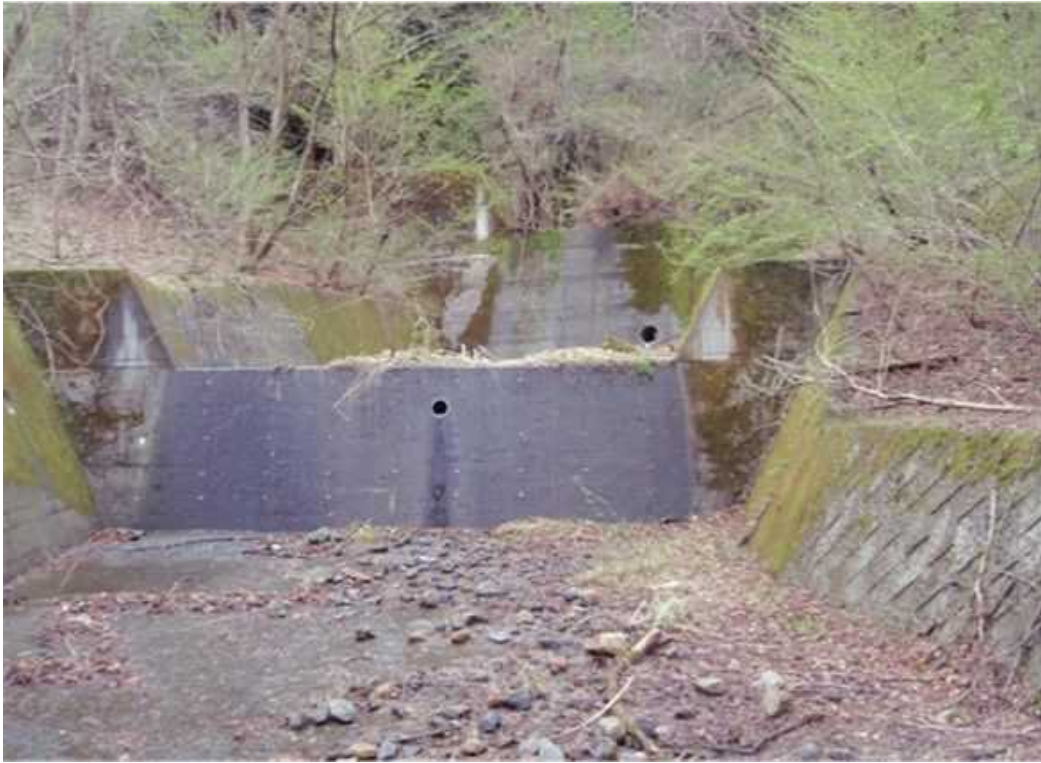
写真 1-4-1 A 沢三面張水路上流
