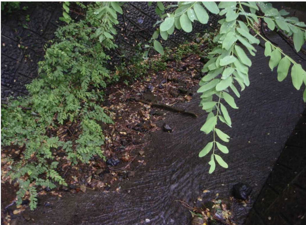
写真 1-4-2 A 沢三面張水路下流
