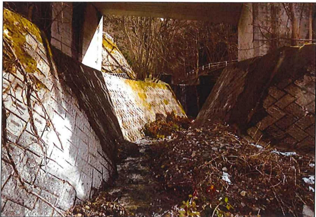
調査地点の状況（A 沢：上流方向を撮影）
