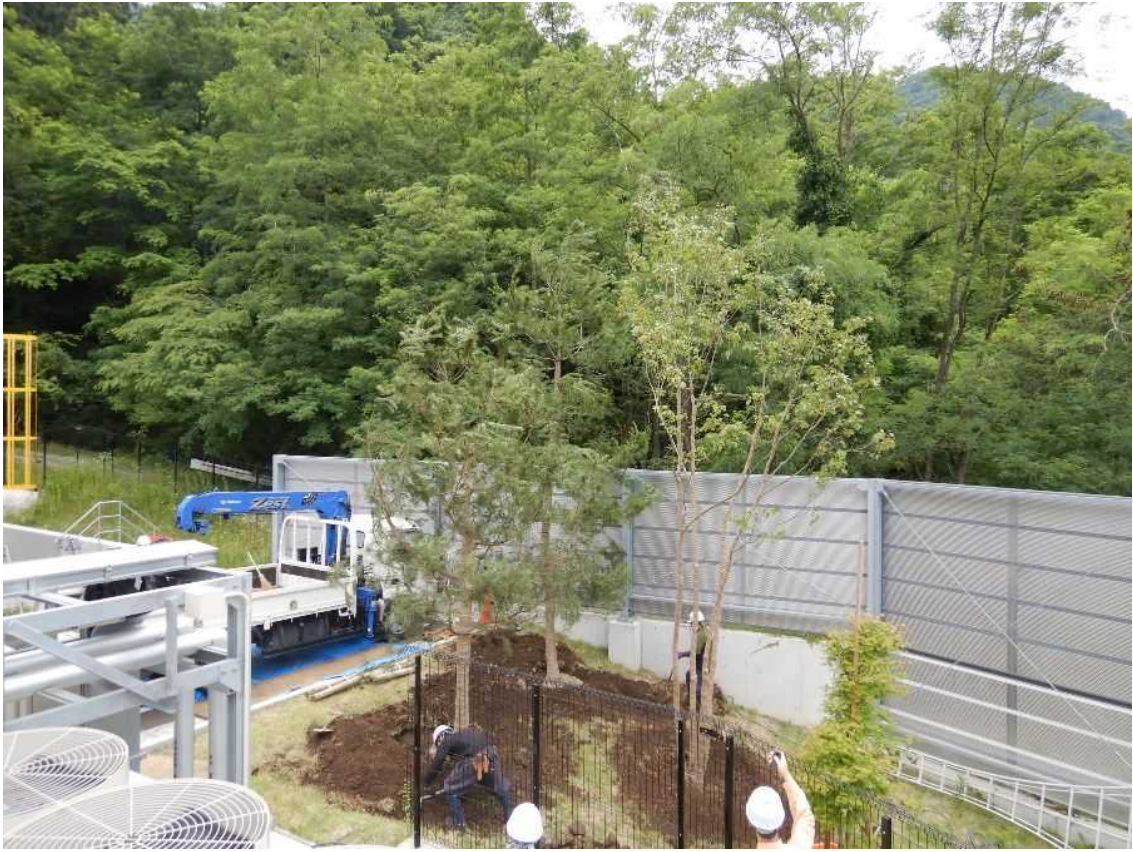
西側植栽工事中写真
