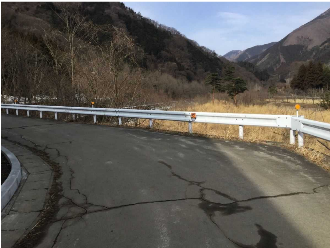
② 敷地北西の笹子川岸のガードレール遠景
