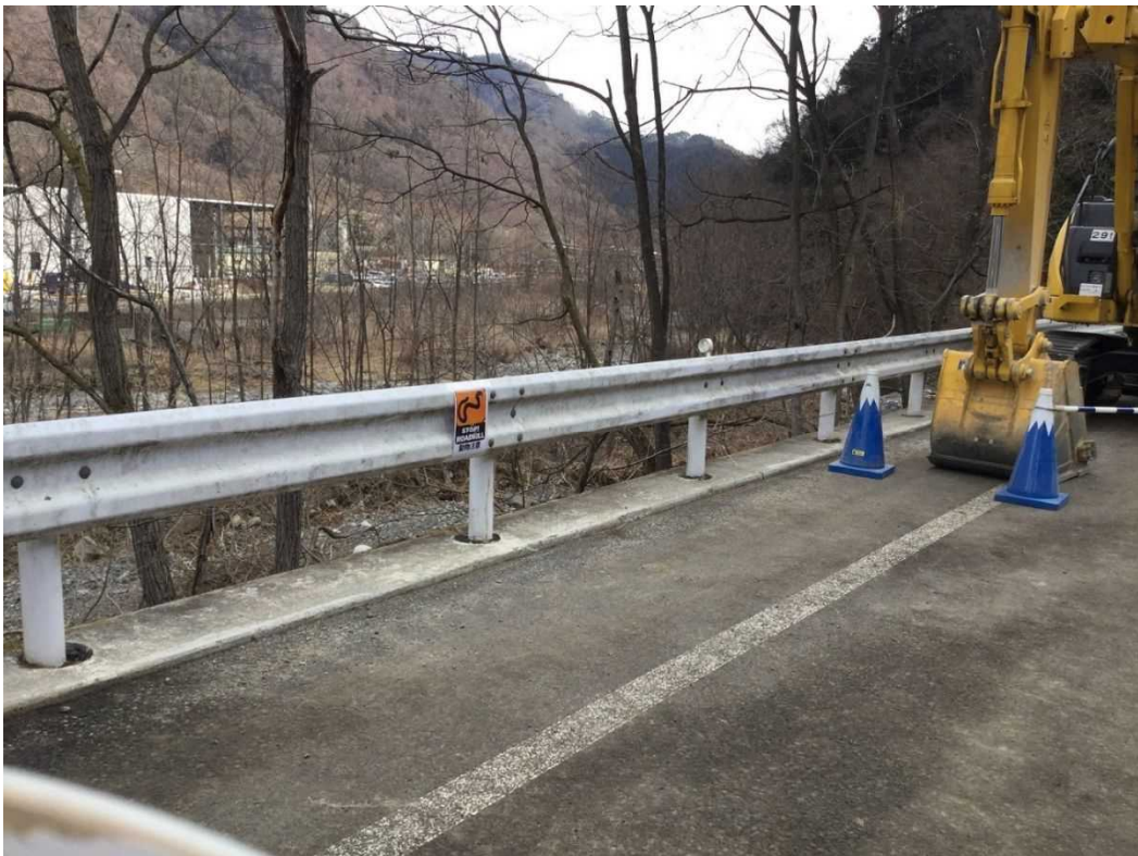
④ 敷地東側の笹子川岸のガードレールの遠景
