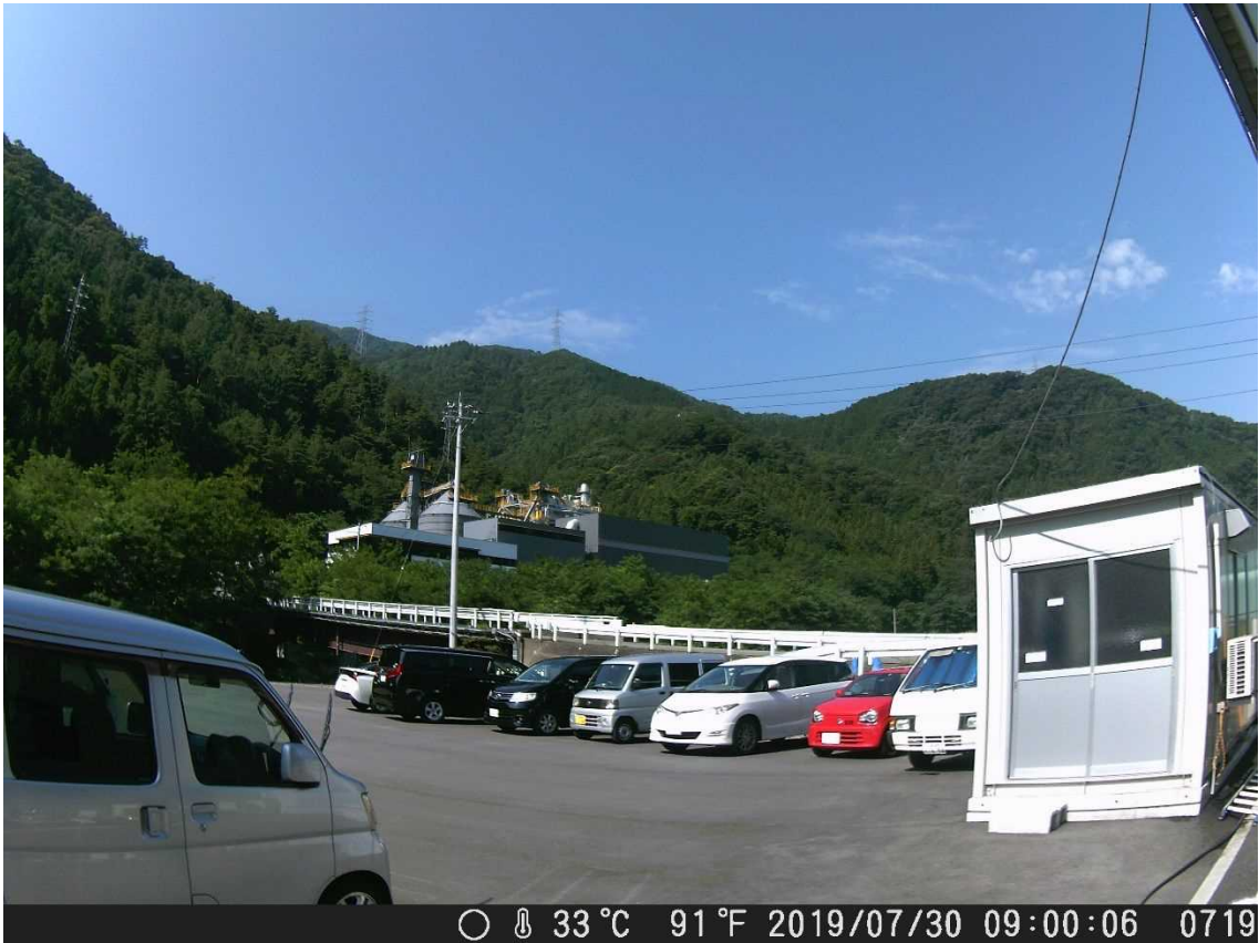
夏期の白煙発生状況写真 (2019年7月30日)
