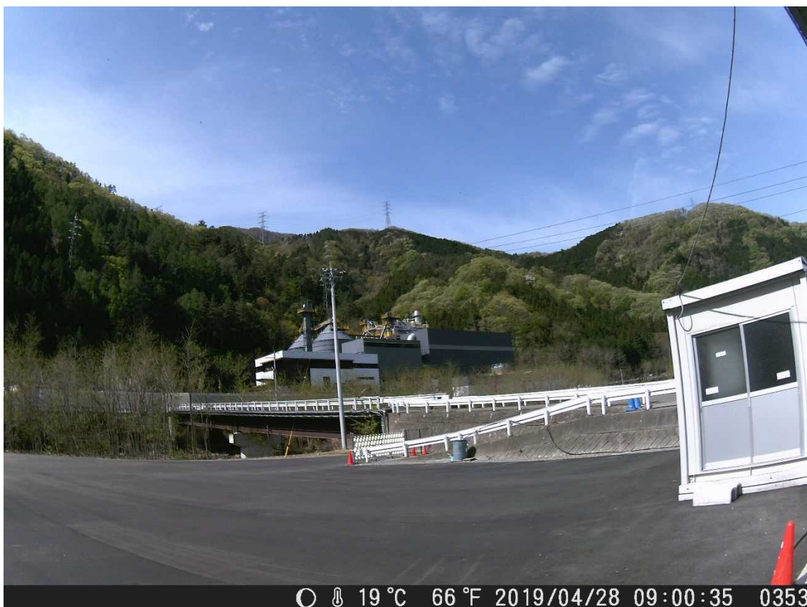
春期の白煙発生状況写真 (2019年4月28日)
