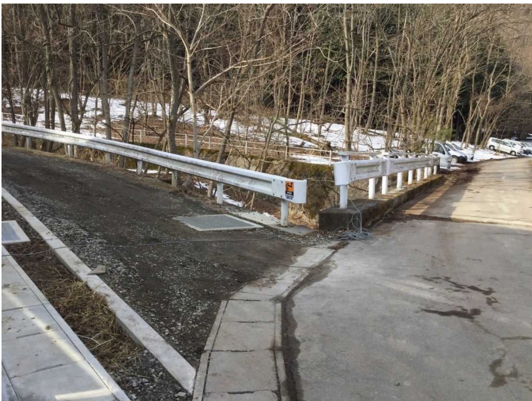
① 敷地西側 A 沢下流地点の橋のガードレール遠景
