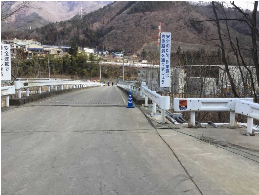
③ 敷地北の橋の袂のガードレールの遠景
