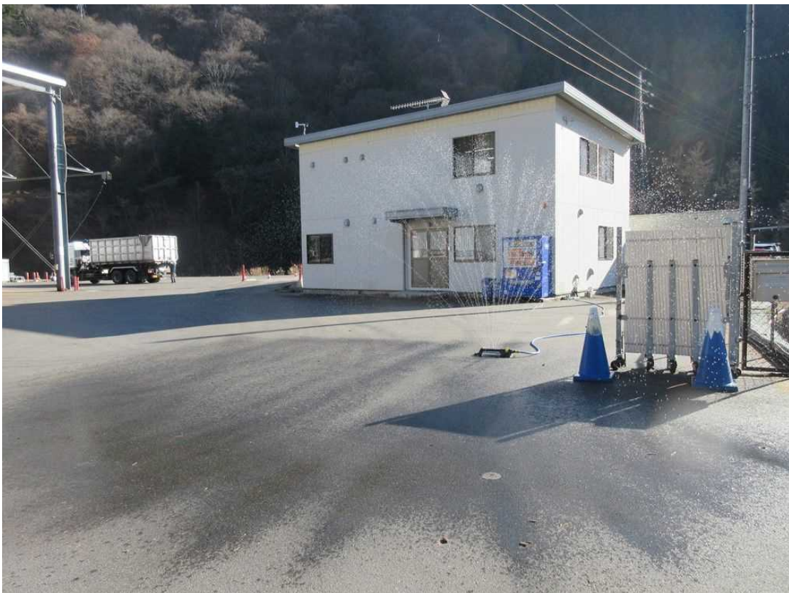
車両出入口付近の路面散水の写真
