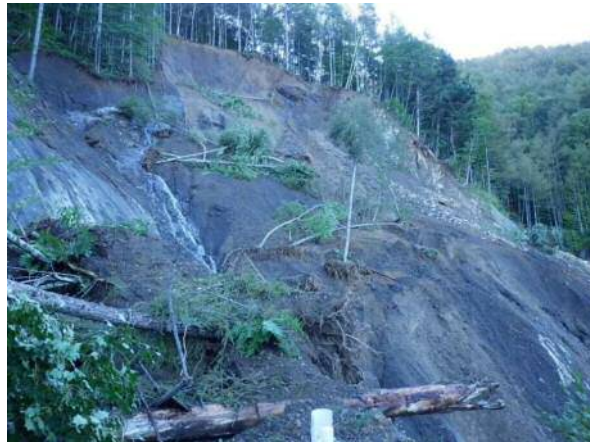
② R1年台風19号災害被災状況
