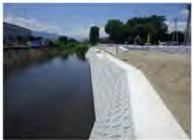
渋川右岸の完了とA1橋台完了
