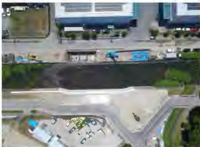
渋川右岸橋台 令和4年6月末の状況
