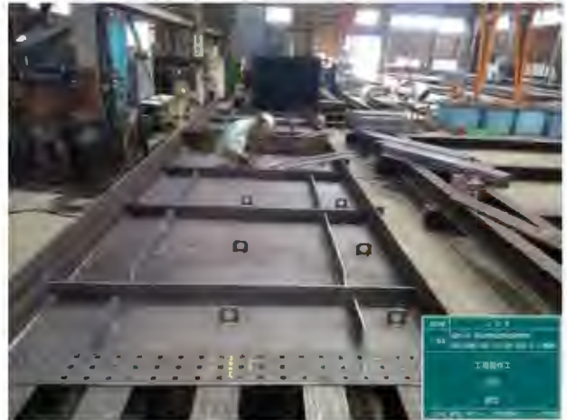
橋桁製作状況
