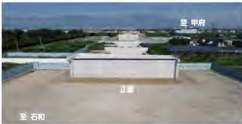
A2橋台 - (ドローン空撮)
