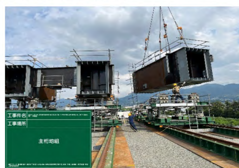
第1回主桁地組立て
