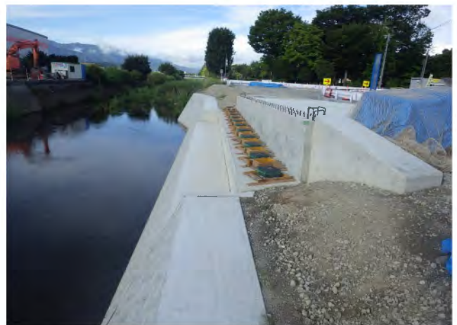
渋川右岸A2橋台 令和4年8月末の状況
