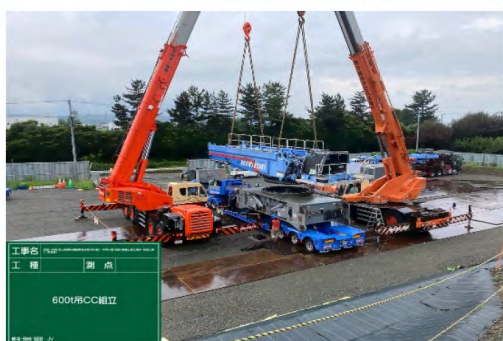
600t吊クローラークレーン組立
