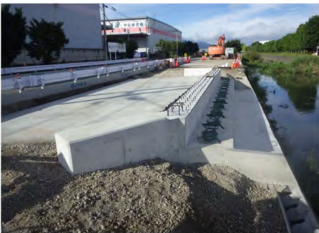
渋川左岸A1橋台 令和4年8月末の状況
