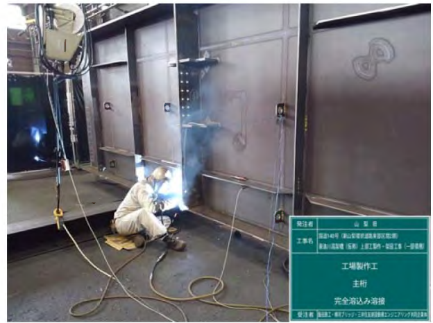
橋桁製作状況
