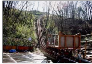
モノレールの仮設
