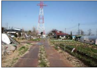
平野部の仮設搬入路(鉄板養生)
