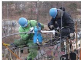
電線を鉄塔に取り付ける様子
