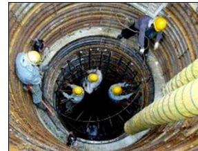
躯体部の配筋
