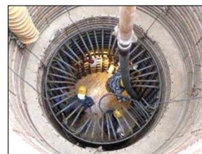
コンクリート打設
