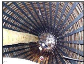
鉄製支保工の土留
