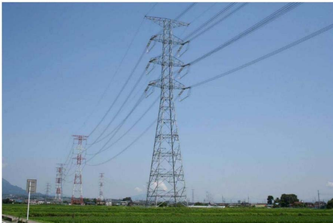
図 1. 3. 3-21 (6) 工事状況の例 (架線工事)
