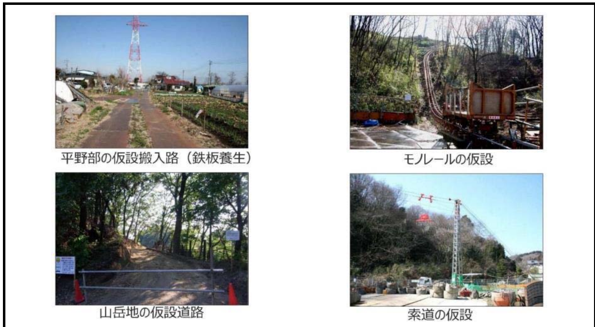
図 1.3.3-18 工事状況の例（仮設工事・資機材の運搬）
