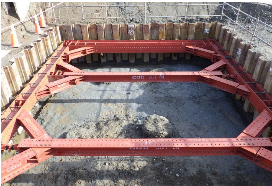
▲翼壁工施工時の鋼矢板等による仮設土留工の施工状況 (オープン掘削から仮設土留工による施工方法に変更し、翼壁工の施工が可能となった。)
