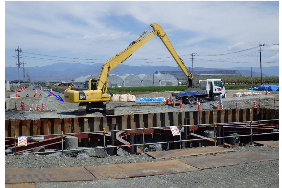
▲堰本体施工時の鋼矢板等による仮設土留工の施工状況 (仮設土留工による施工方法に変更し、堰の施工が可能となった。)
