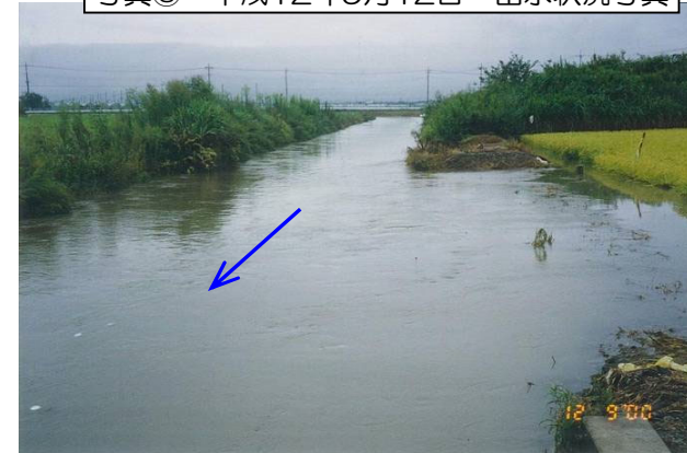
写真③ 平成12年9月12日 出水状況写真
