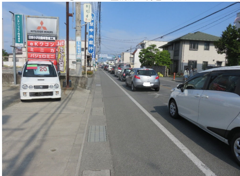
① バイパス整備前の現道の状況
