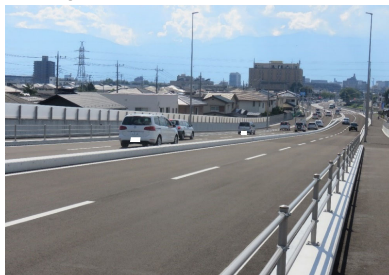
④ 整備後 (バイパス供用開始状況)
