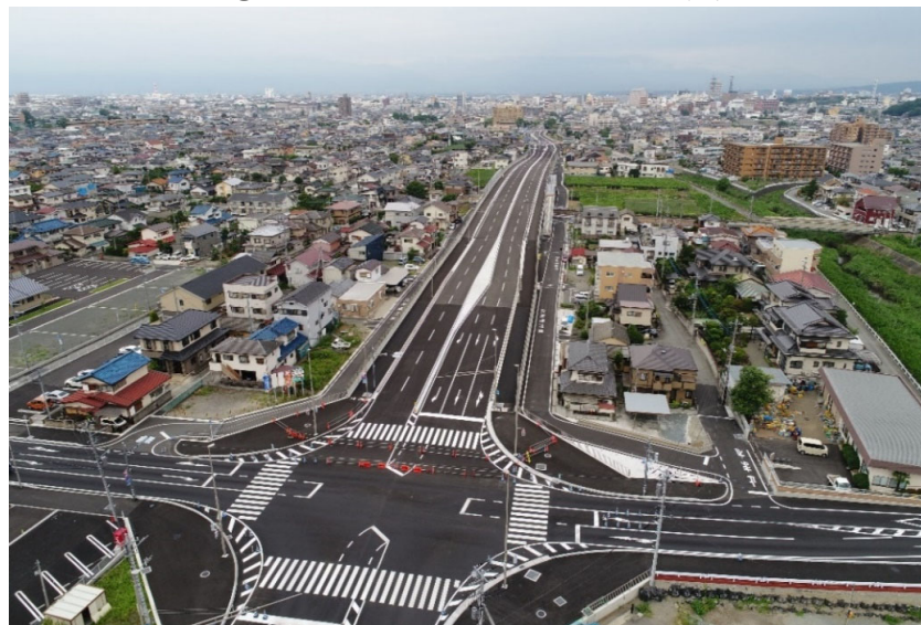
③ 整備後 (供用開始前航空写真)
