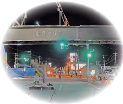
1位 歩道橋架設
