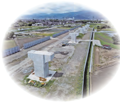
8位 国道140号橋梁下部工事
