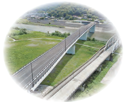
3位 「富士橋」竣工
