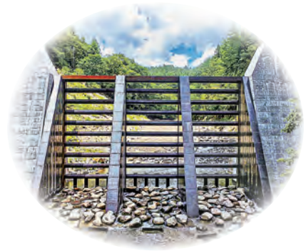
9位 日川（塩山）砂防堰堤改修工事
