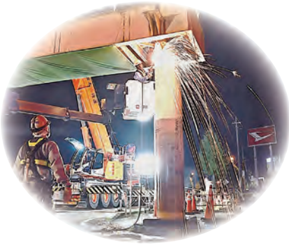
3位 歩道橋撤去
