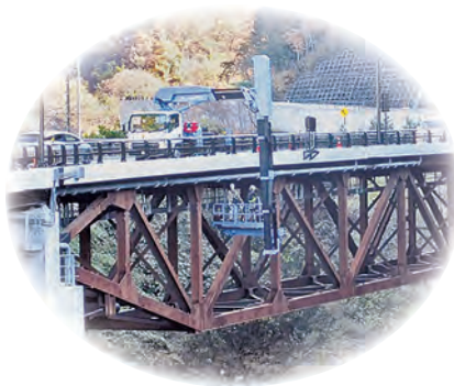
2位 中之倉バイパス橋の点検
