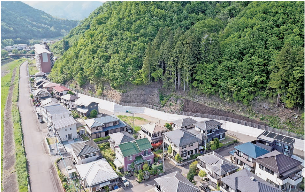
沢戸 急傾斜地崩壊対策工事（都留市）
