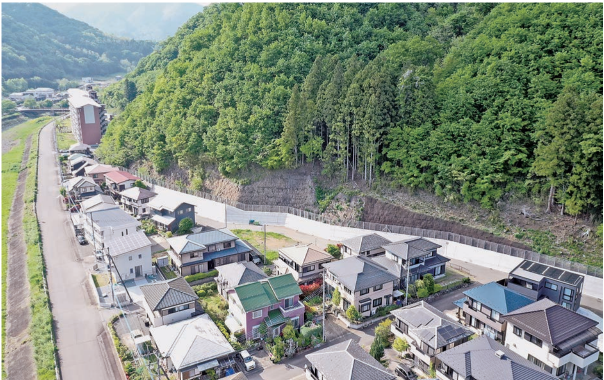
沢戸 急傾斜地崩壊対策工事（都留市）
