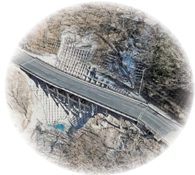
南アルプス公園線 道路災害復旧工事
