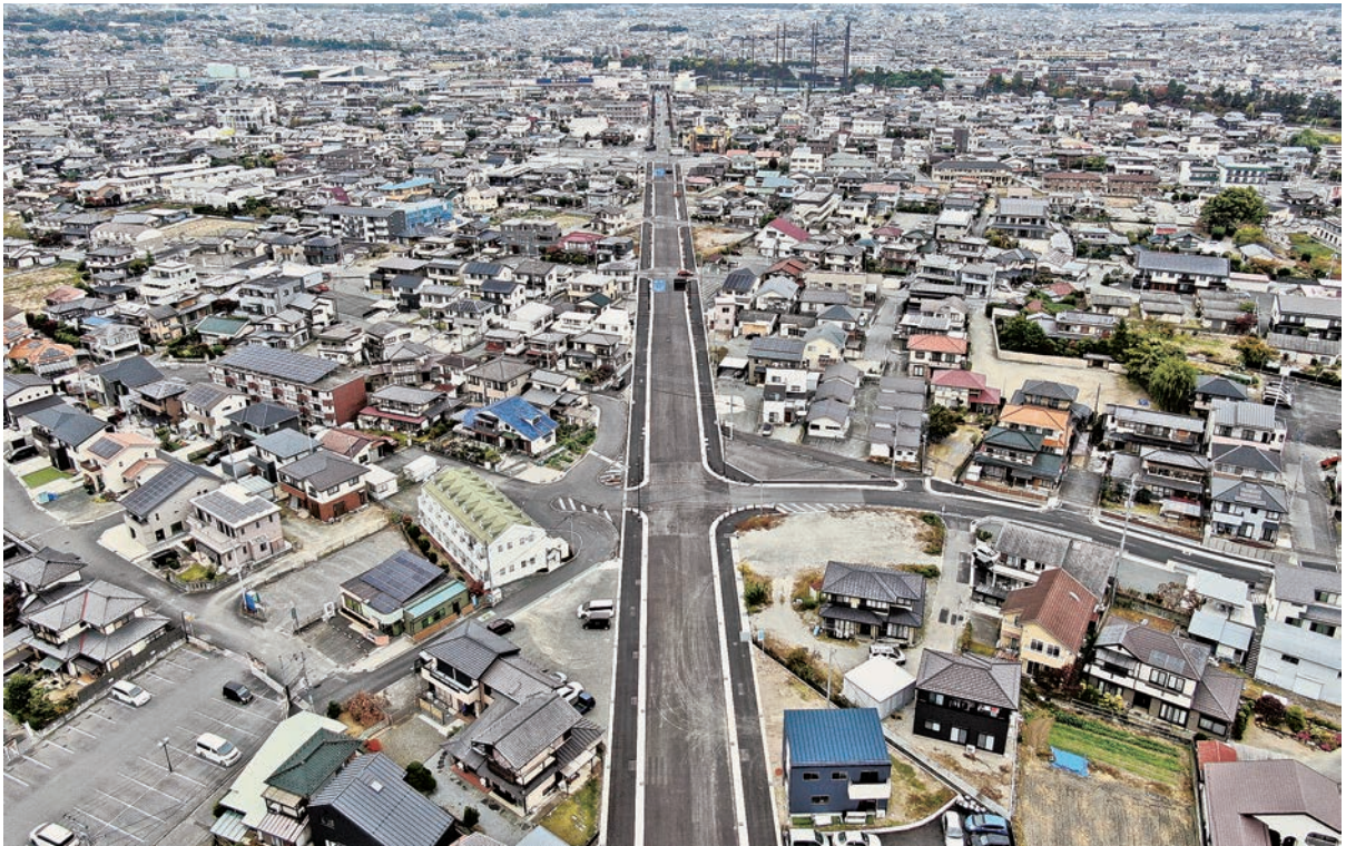
都市計画道路 田富町敷島線
