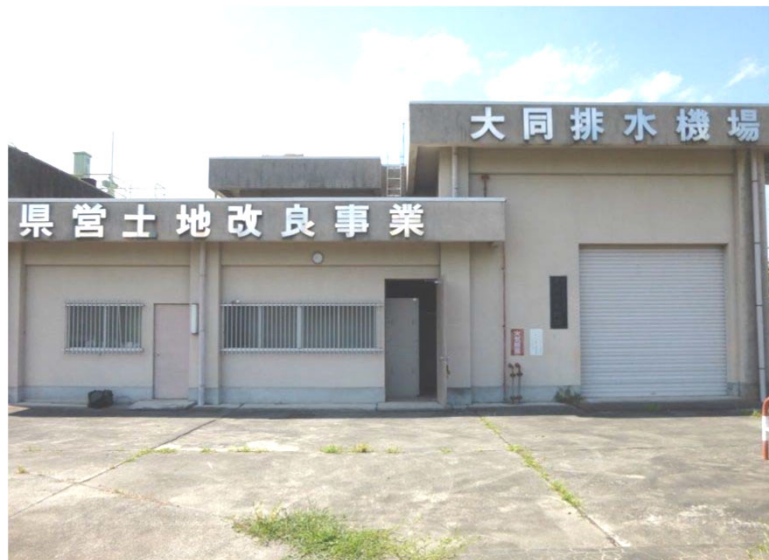
①大同排水機場の全景
