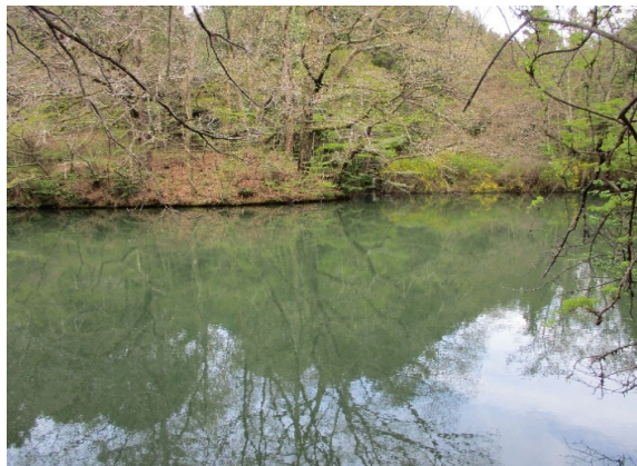
① 菖蒲池 全景 貯水量 4,000m 3 、堤高 H=7.8m
