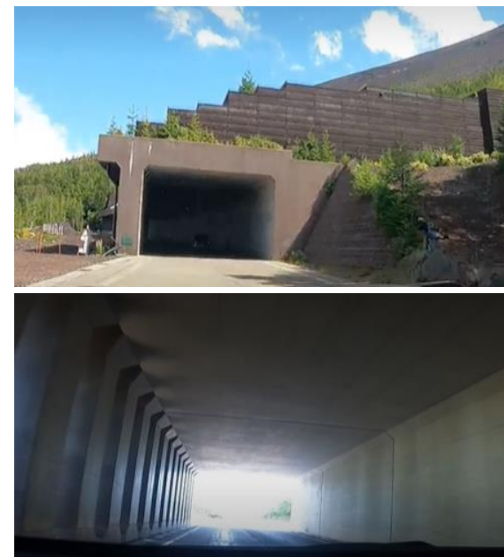
写真：洞門の例(富士スバルライン 御庭洞門)
