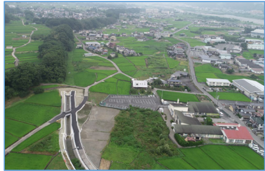
古川 (河川改修)
