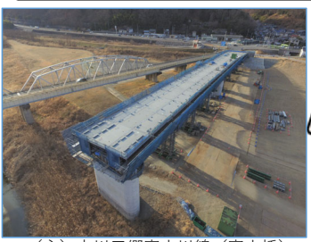
(主) 市川三郷富士川線 (富士橋) 橋梁上部工着手
