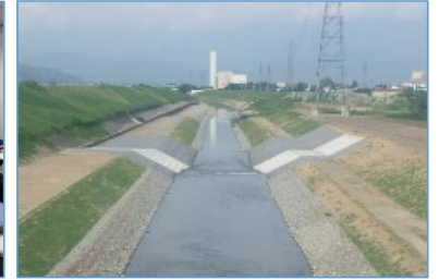
鎌田川 (河川改修)
