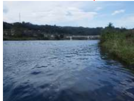
下流側（桂川橋）
