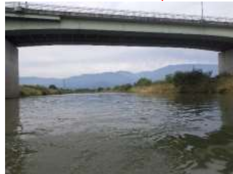
下流側（桃林橋）
