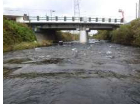
下流側（小明見橋）
