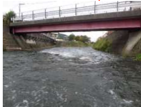
下流側（柿林橋）
