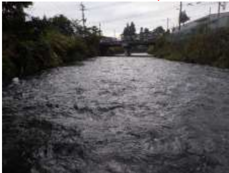
上流側（昭和橋）
