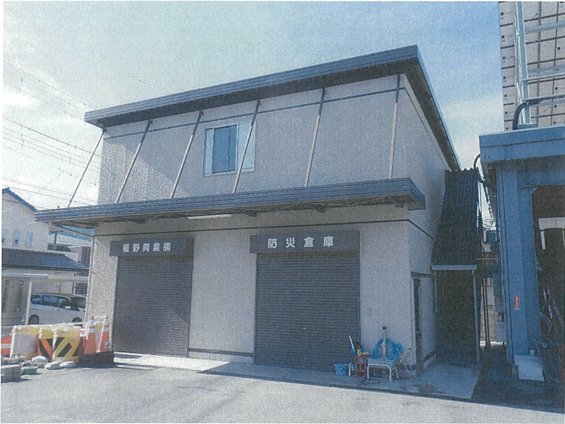
写真「防災倉庫外観」
