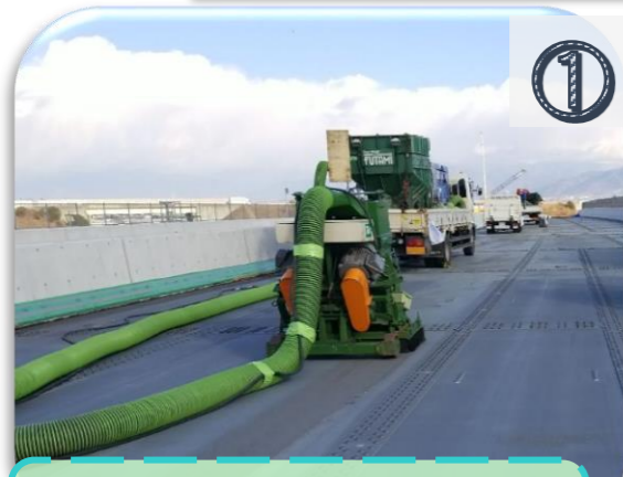
まずは、表面に付いている“汚れ”や“サビ”を取ります。
