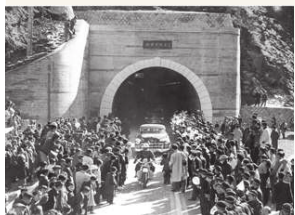
新笹子トンネル開通
